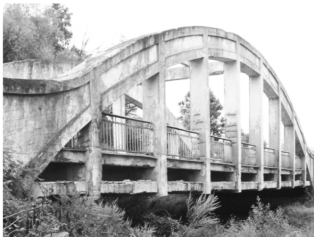
Vlani v lete pred rekonštrukciou mal starosta J.Ivic ešte vážne obavy z toho, ako dlho bude most odolávať nátlaku dopravy. V zlom stave totiž nebol len oblúk, ale aj nosná časť, ktorá sa rozpadávala pred očami...
